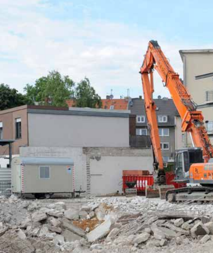
BONNER WALL 118 entsteht
